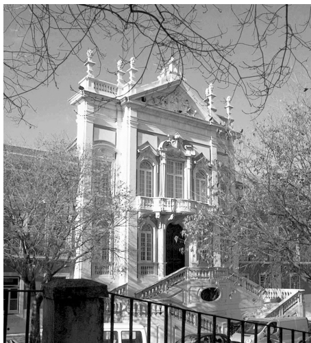
Figura 1 – Fachada principal da Capela da Bemposta.
